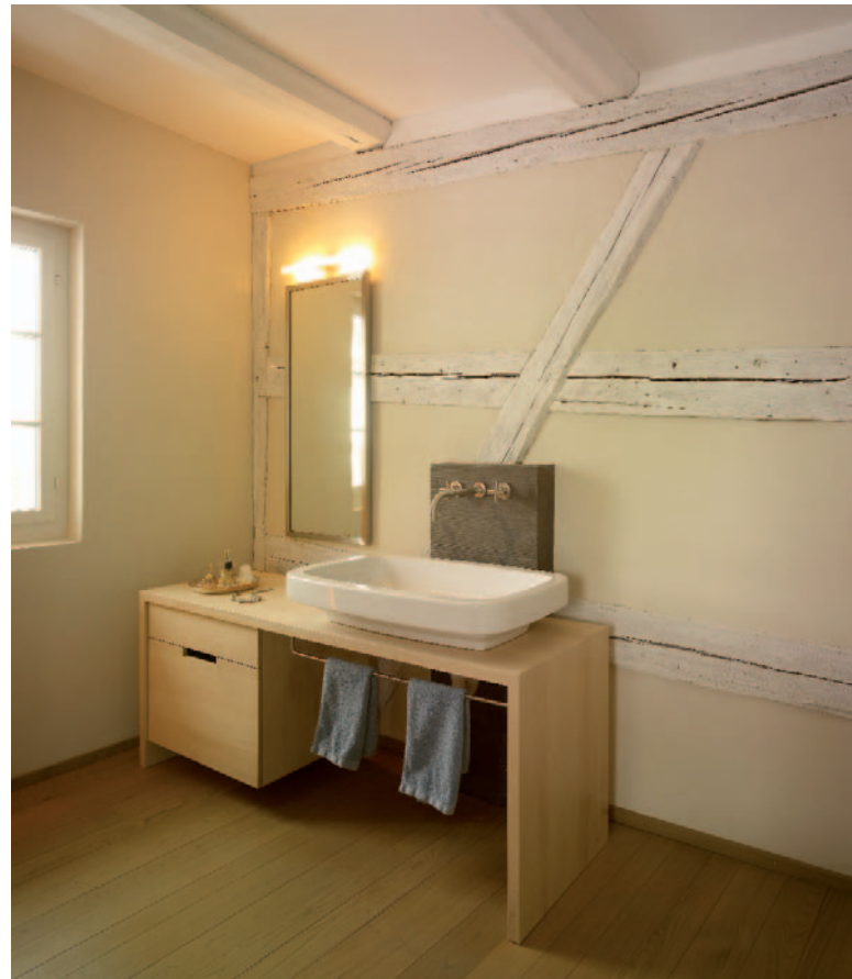
Lehmanwendung im Riegelgeschoss eines alten Thurgauer Hauses: Lehmbauplatten als Vorsatzschale zur Aufnahme der Zelluloseflockendämmung, verputzt mit eingefärbtem Lehm
