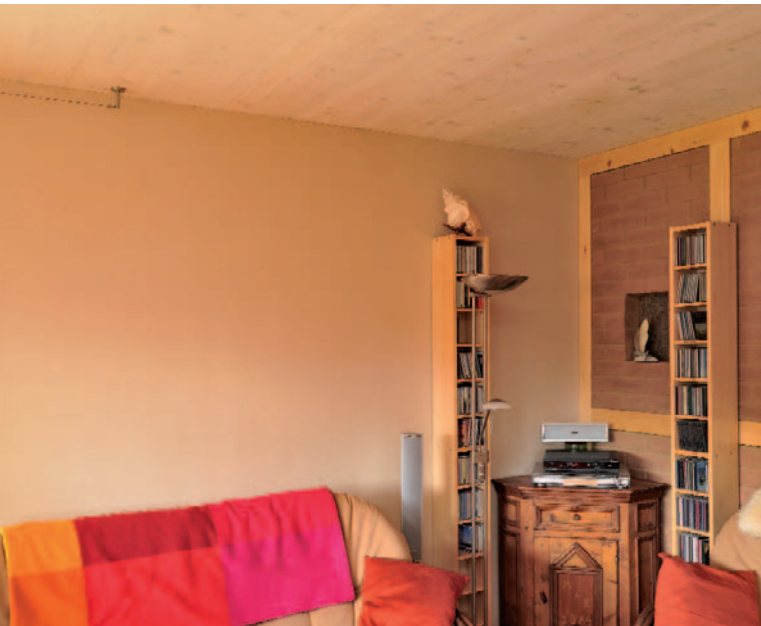
Anwendung von Lehmbauplatten, Lehmputz und Lehmsteinen im Wohnraum eines Holzelement-Neubau
